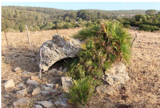
Fig. 7 : Voûte du bassin de décantation de l'aqueduc occidental rappelant celui de l'aqueduc septentrional © L. Borau
